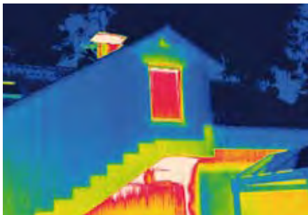
Abb. 10 und 11: Foto- und Thermographieaufnahme eines beheizten Treppenhauses mit dem Treppenlauf als Beispiel einer materialbedingten Wärmebrücke.
