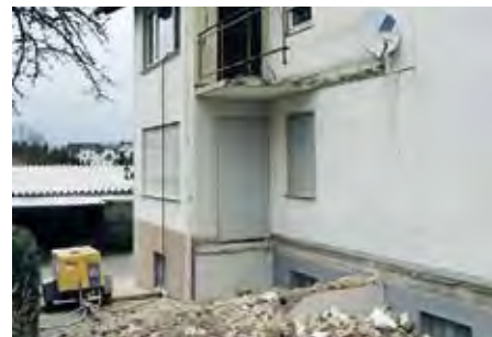
Abb. 55: Abbruch von Stahlbetonplatten zur Wärmebrückenvermeidung
